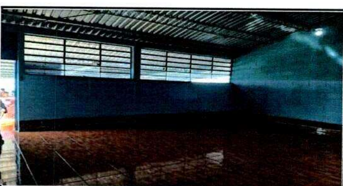
FOTO 6 Sustitución de piso cerámico
