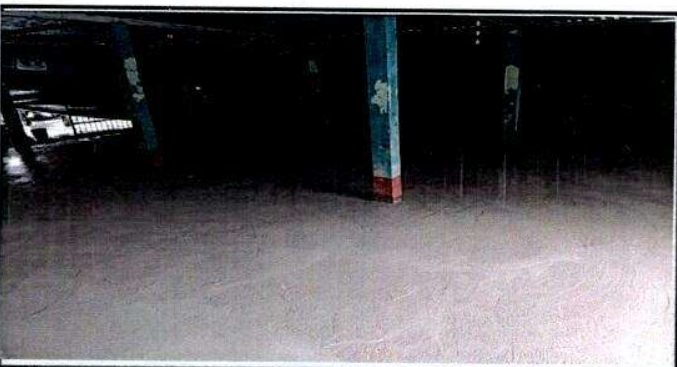
FOTO 5 Sustitución de piso de torta de concreto
